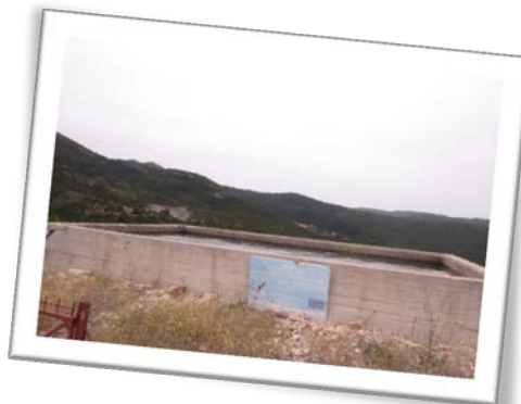
Υδατοδεξαμενή στην Περιοχή Ξηροκάμπι Αγίου Πέτρου Αρκαδίας.
