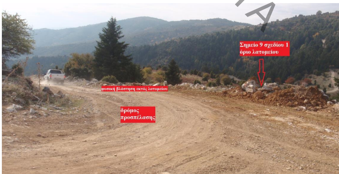
Φωτογραφία 4 Δυτική πλευρά λατομείου
