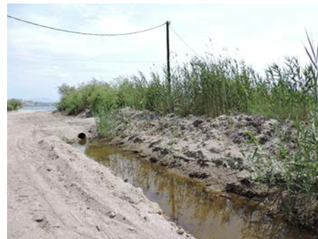
Επιχωμάτωση τάφρου και τοποθέτηση αγωγού αποχέτευσης
