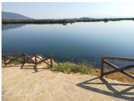
22.6.2019 Κατεστραμμένα ξύλινα κικλιδώματα στην περιοχή του Μουστού.
