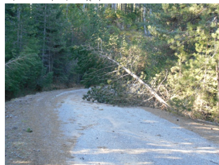
22.3.2019 Καταστροφές στο ορεινό οδικό δίκτυο από πτώση δέντρων.
