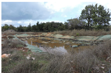
4.11.2019 Από τη διενέργεια ελέγχου σε οικόπεδο όπου λειτουργεί λιμνοδεξαμενή εξάτμισης-οξείδωσης υγρών αποβλήτων ελαιουργείου
