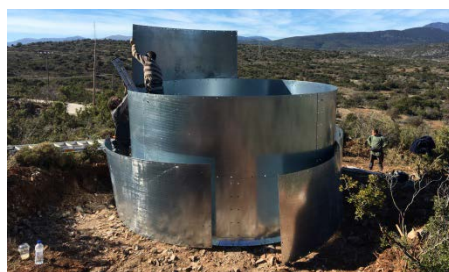
Από την εγκατάσταση δεξαμενής στη θέση Βασκίνα – Νότια Κυνουρία
