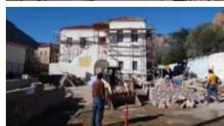
12/2015 Εργασίες σε εξέλιξη στο Λεωνίδιο στο Κέντρο Πληροφόρησης Λεωνιδίου για τη Χλωρίδα του Πάρνωνα
