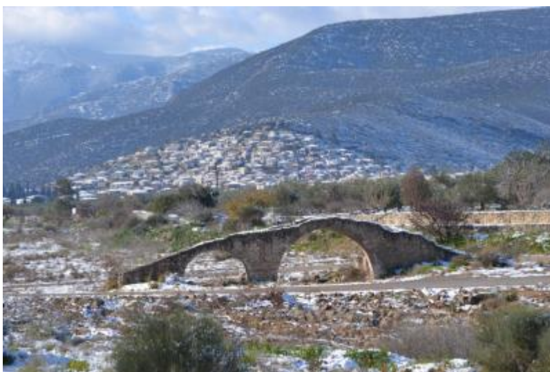
Γεφύρι στο Ρέμα Βρασιάτη
