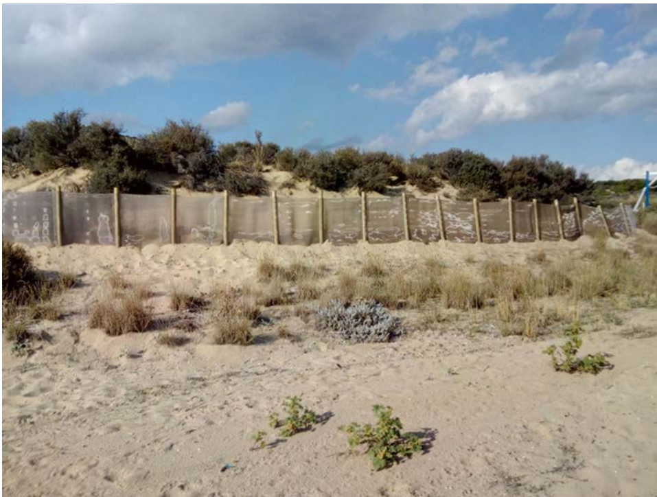
Εικόνα 8: Φωτογραφία από τοποθέτηση ανεμοφραχτών (παγίδων) σε αμμόλοφους.
