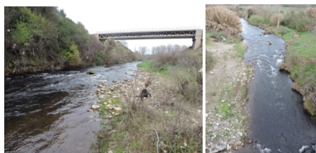
11.01.2021 Ενδείξεις ρύπανσης από απόβλητα (ελαιολύματα, πούλπα εσπεριδοειδών) στη γέφυρα του Βρονταμά (αριστερά) και της Χιλιμοδούς (δεξιά) αντίστοιχα, στην περιοχή του Ευρώτα
